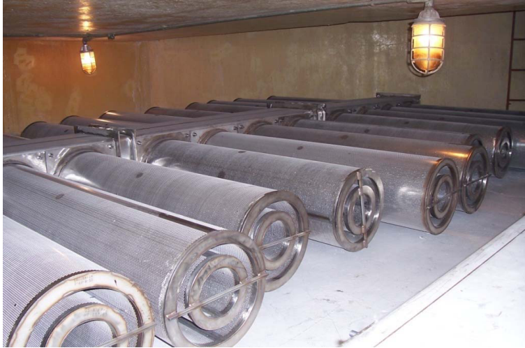
Figure 5.11-5. H. B. Robinson Strainer (NRC, 2008b)
