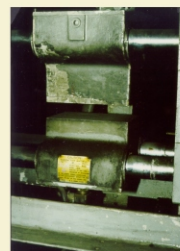
MEDIDOR MONTADO SOBRE OTRO EQUIPO
