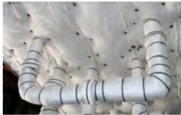
#106: Conduit 1C hot.
