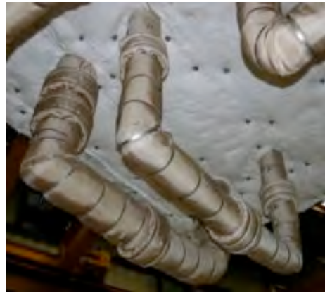
#58: Conduits 1A & 1E completed.
