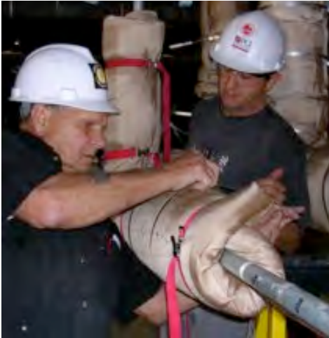
#43: Cladding LB on conduit 1E.
