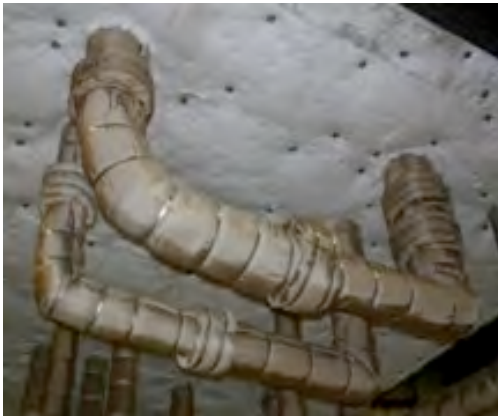
#57: Conduits 1A & 1E completed.
