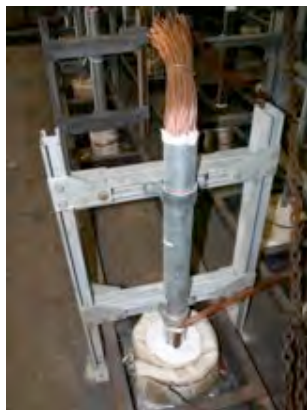
#89: Top side, conduit 1D.
