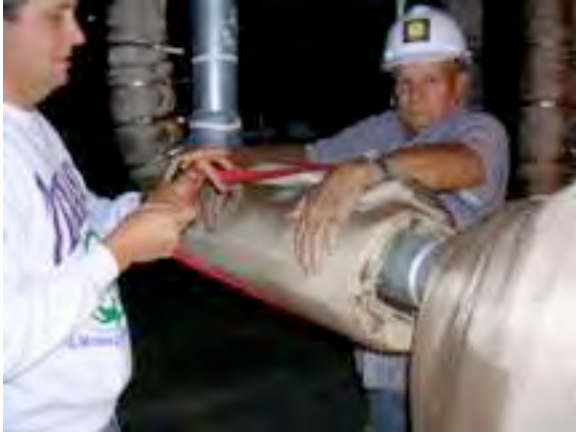
#31: Cladding conduit 1B.
