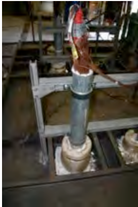
#93: Top side, conduit 1B.
