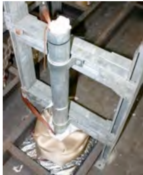
#88: Top side, conduit 1C.
