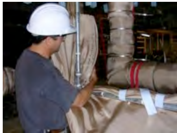
#42: Cladding LB on conduit 1E.
